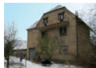
Obr. 11. Praha 11-Újezd, čp. 2, obytný dům v areálu Koničkova mlýna. Pohled na dům čp. 2 od východu (foto archiv NPÚ ÚOP v hl. m. Praze, J. Baláček, 2009).
