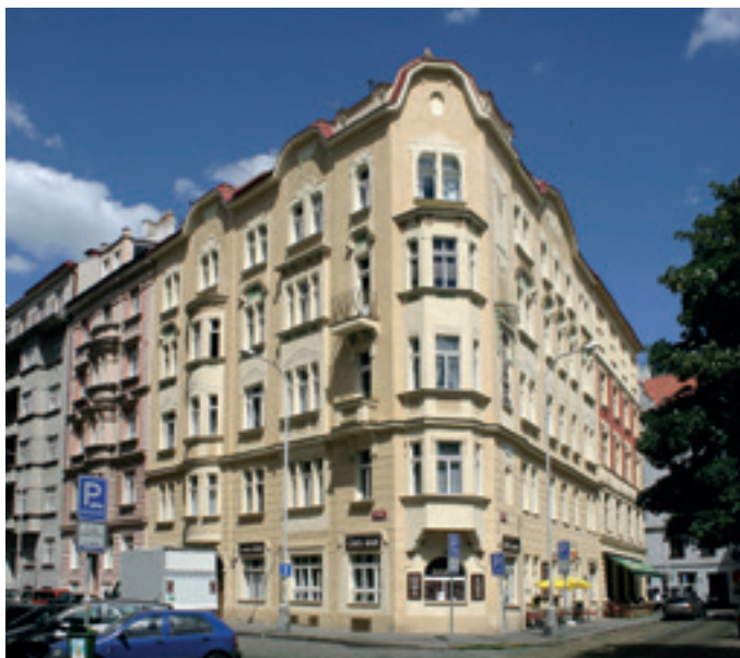
Obr. 2. Praha 2-Nové Město, čp. 2034, dům stavitele Štěpánka. Celkový pohled od západu (foto archiv NPÚ ÚOP v hl. m. Praze, M. Kracík, 2012).
